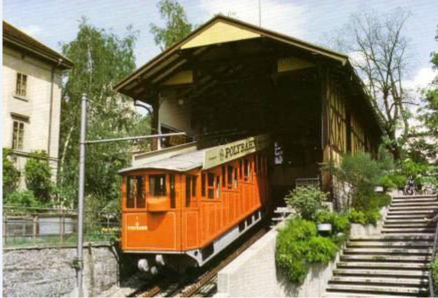
Polybahn, Bergstation, 8001 Zürich
